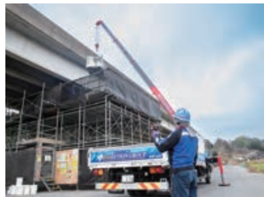
様々な特殊車両を保有しているEVO。操作を行う重機オペレーターたちも習熟しており、スピーディーかつ安全に現場作業を進めていく。
