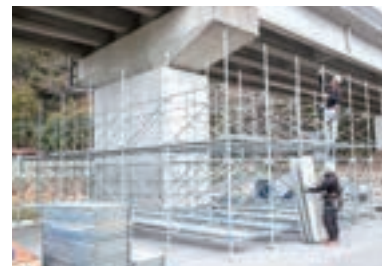
補修・耐震補強工事に必要な足場の組み立てから自社で行うことができる。
