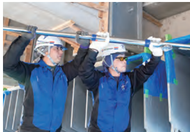
安全で確実な工事のためにはチームワークがとても大切となる。
